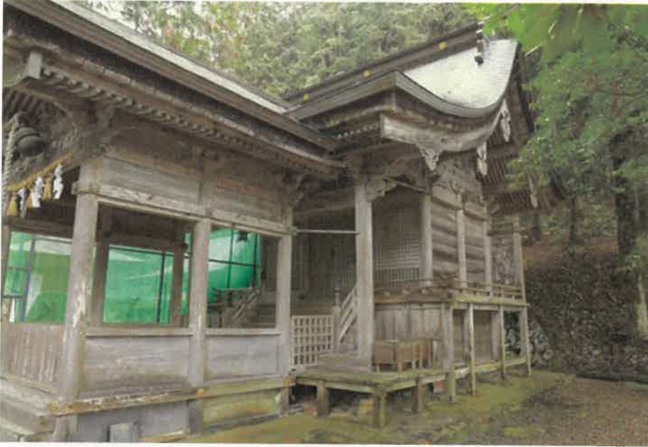
しゅじ し じんじやほんでん 酒治志神社本殿 (京丹波町)
